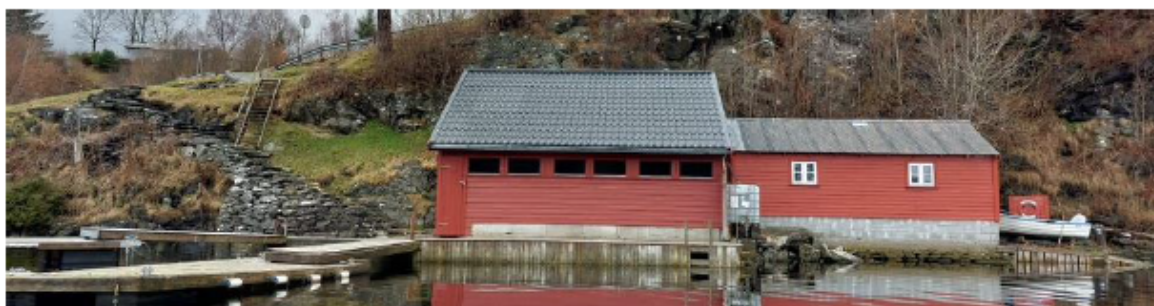
Figur 4. Bilete tatt frå sør av tiltaket på gbnr 347/99.
