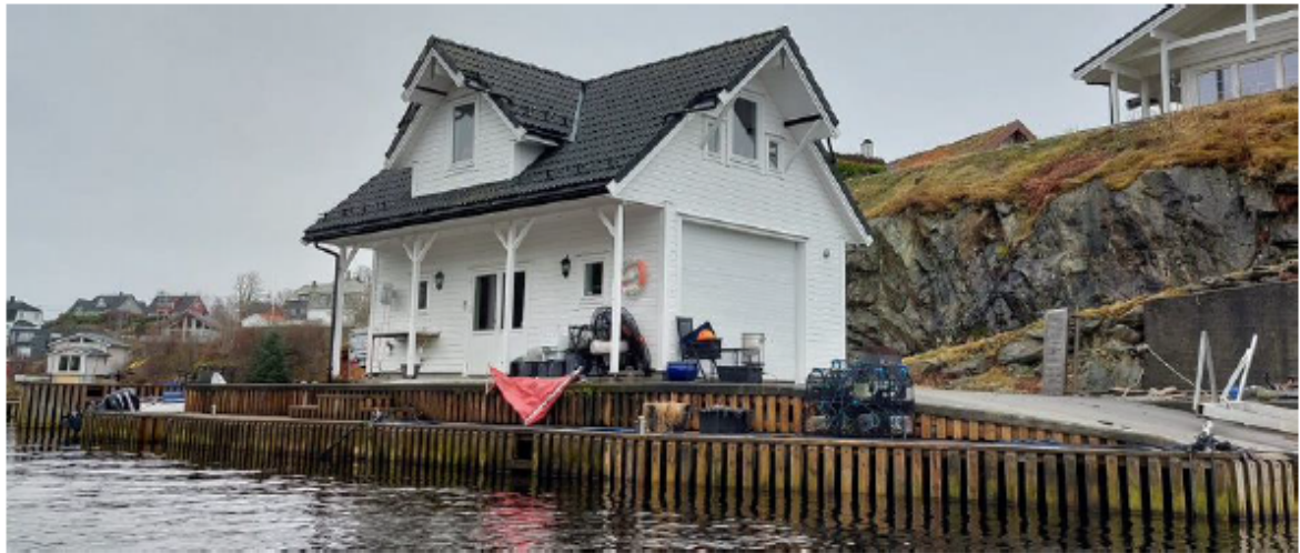
Figur 1. Bilete tatt frå nord, av tiltaket på gbnr 345/127.
