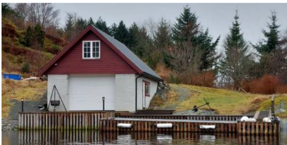
Figur 5. Bilete tatt frå nord av tiltaket på gbnr 345/125.
