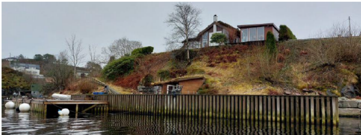
Figur 3. Bilete tatt frå nord av tiltaket på gbnr 345/126.
